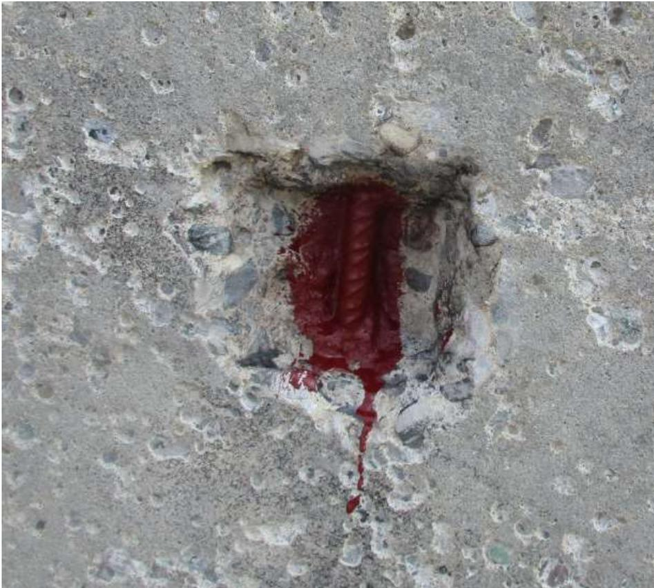
Die frei liegende Armierung wurde gereinigt und mit Rostschutz versehen. Loch kann jetzt mit Feinputz verschlossen werden.
